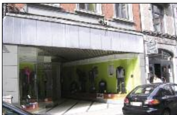
EL PASO - Rue Grande 138
