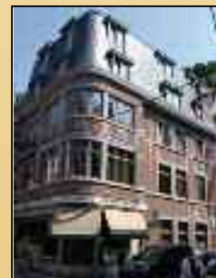
Façade Boulangerie- Pâtisserie Maison JACOBS Rue Grande, 147
