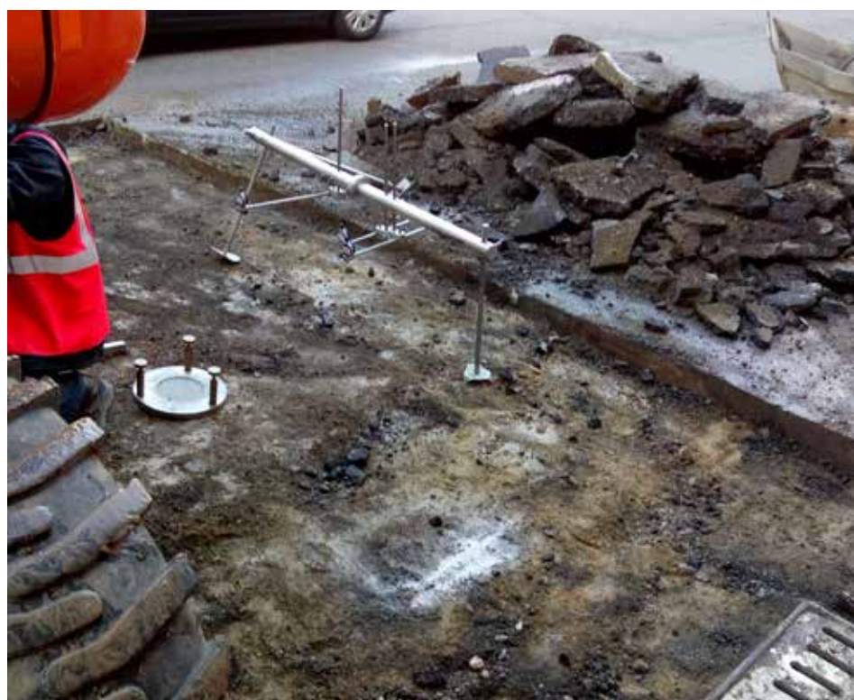
Des sondages ont eu lieu préalablement au début des travaux pour mieux connaître la nature du sol et intervenir en conséquence.
